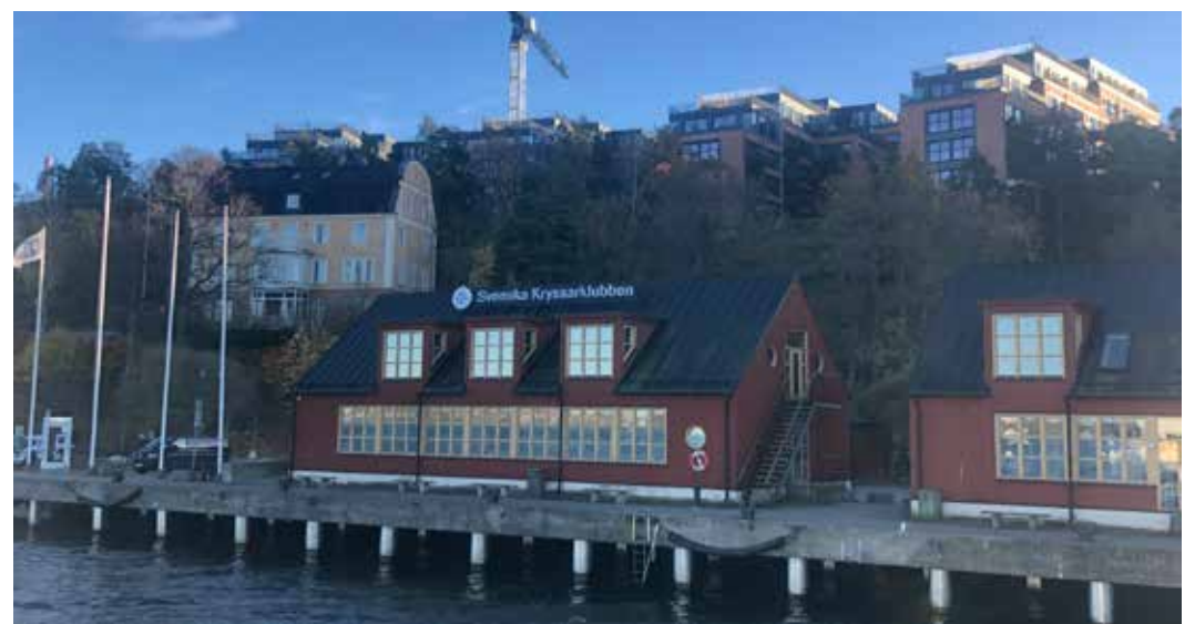
Kajanläggning har funnits sedan 1800-talets första hälft på platsen. Kajen har successivt byggts ut. Dagens anläggning är sentida med "hamnmagasin" från 1990-talet.
