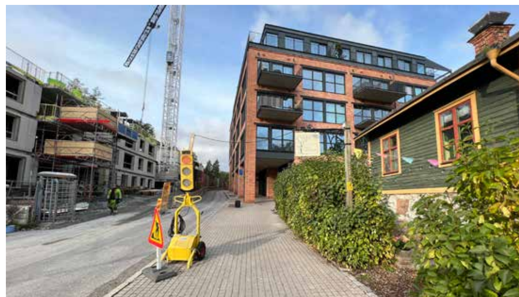
Fabrikörvägen med Kuskbostaden. I bakgrunden postmodernistisk bostadsbebyggelse.
